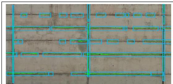
Рис. 6. Пример обнаруженных разрушений швов
